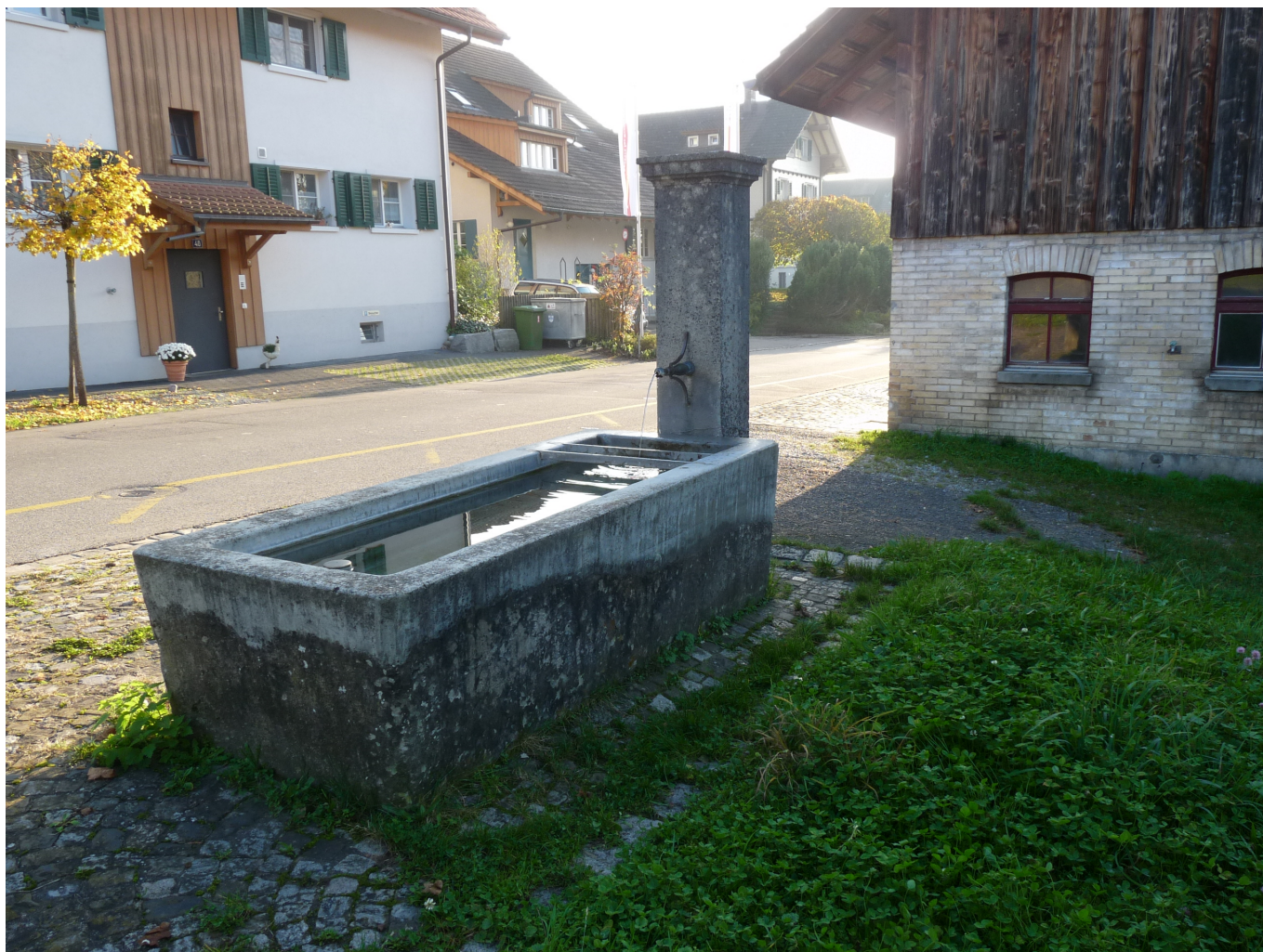
Brunnen an der Eidbergstrasse 39
