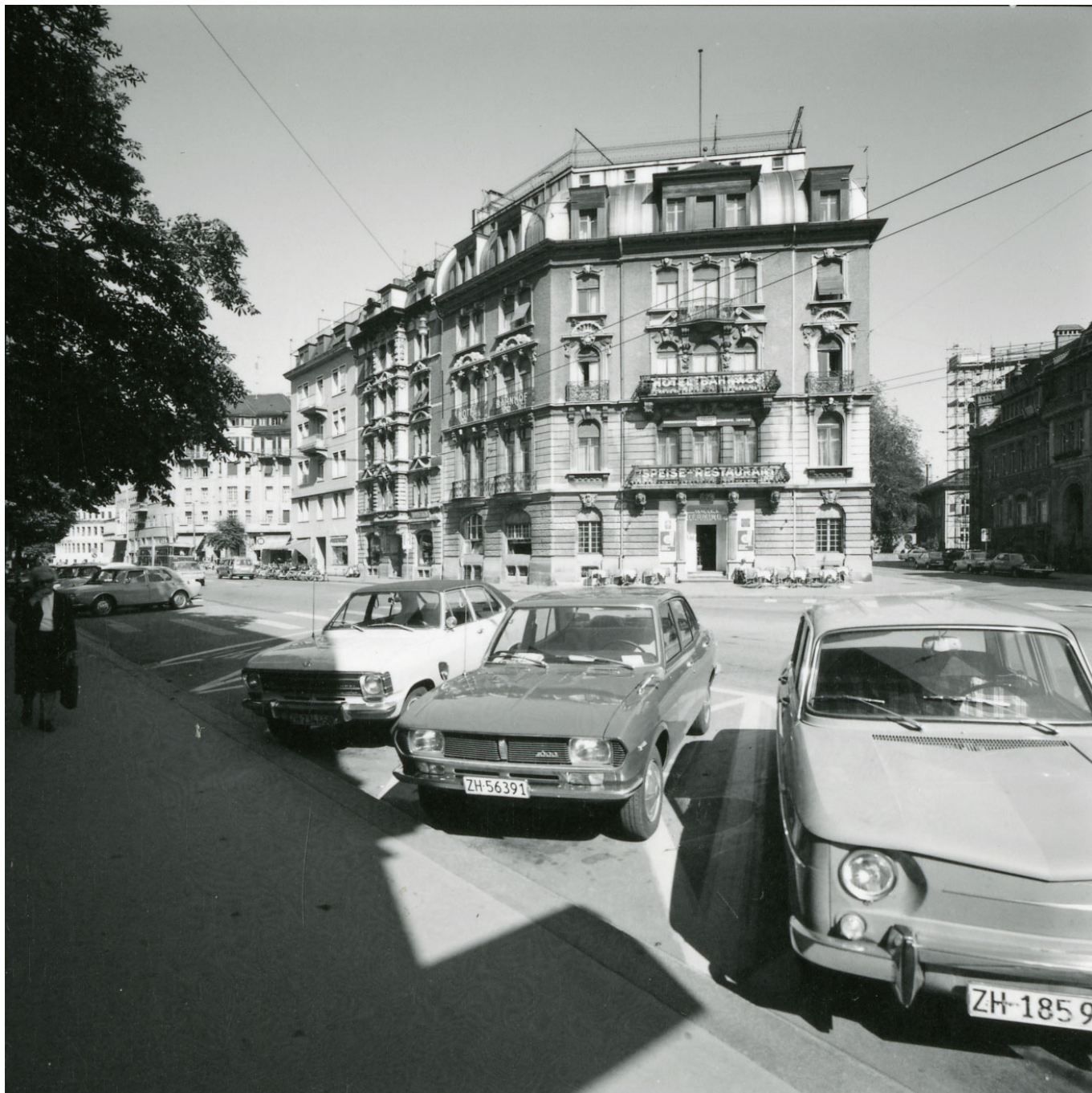
1974: Bahnhofplatz Nord, Terminus-Areal, parkierte Autos und Hotel Terminus Foto: winbib, Michael Speich (Signatur FotSpeich_009-057)
