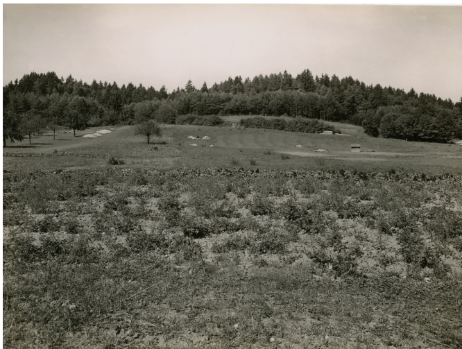
Areal vor Baubeginn, 1933 Foto: winbib (Signatur 066743)
