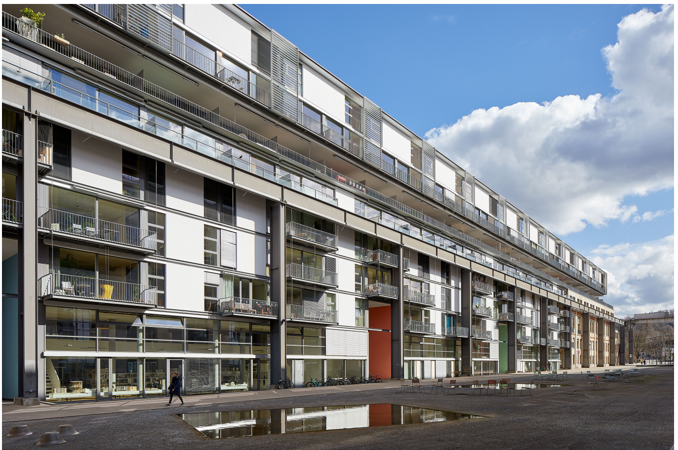
2020: Katharina-Sulzer-Platz, Sulzerareal, Wohnüberbauung Kranbahn Foto: winbib, Andreas Mader (Signatur FotDig_Mader_0177)
