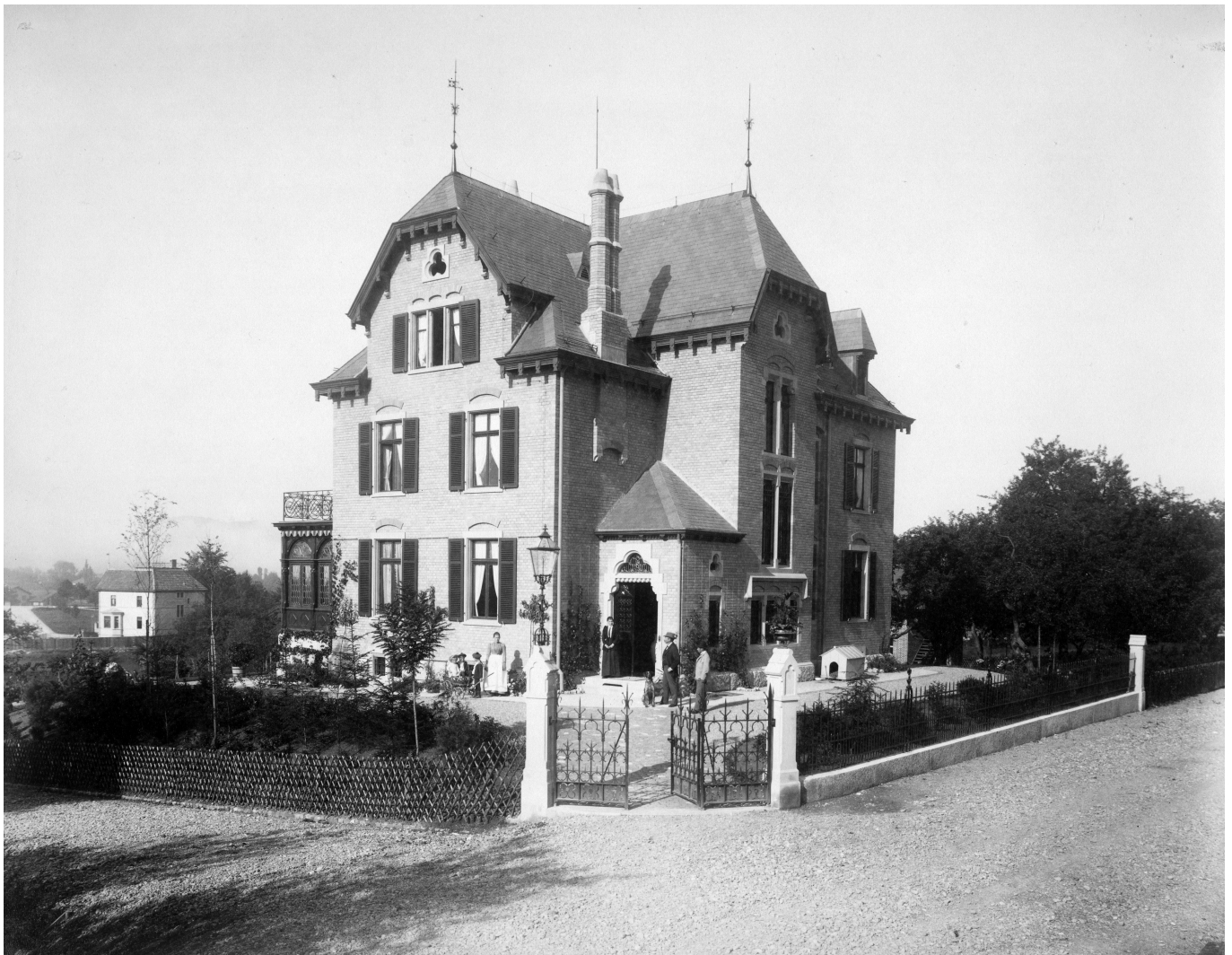
1890er-Jahre: Rychenbergstrasse 82, Villa Ziegler, erbaut 1891
